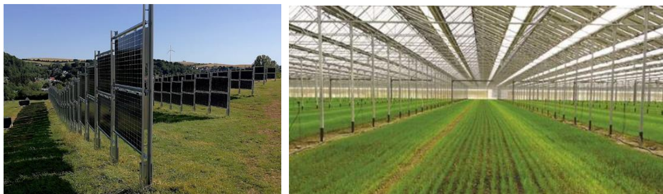
Figure 29. Panneaux verticaux bifaciaux (photo 1) et serre photovoltaïque (photo 2) (Next2Sun, Ténergie)
