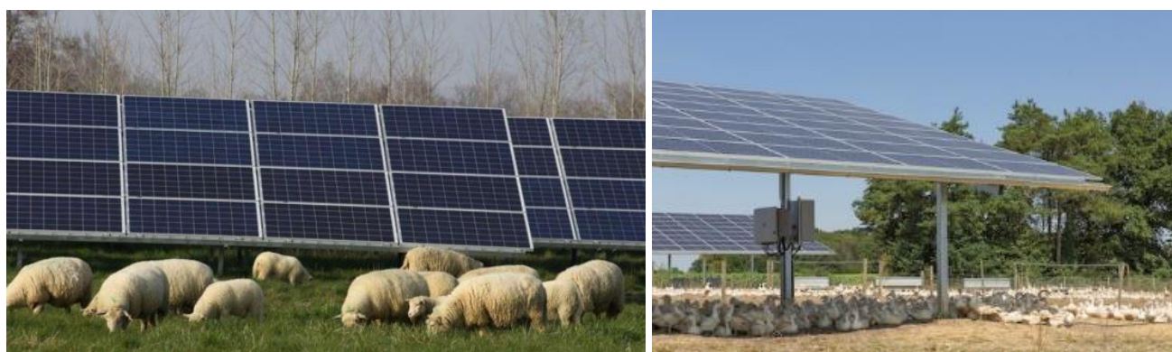
Figure 28. Centrale agrivoltaïque avec ovin (photo 1) et ombrières photovoltaïque pour volailles (photo 2) (NOVAFRANCE)
